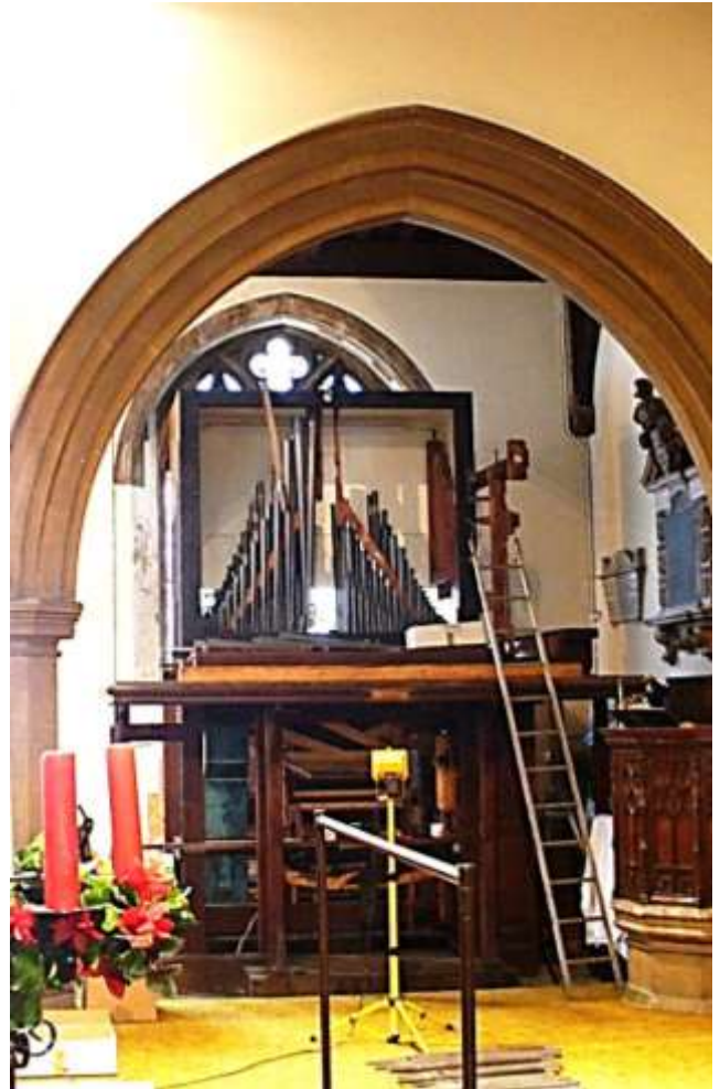
L'orgue en cours de démontage
